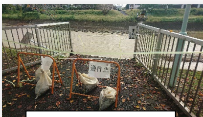
被災後の状況
