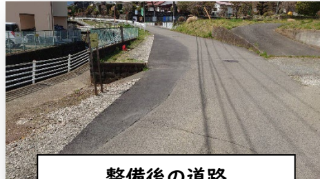
整備後の道路
